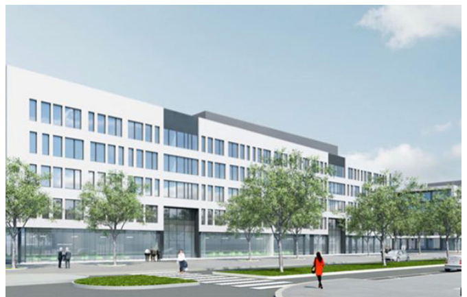
Atenor : deux immeubles de bureaux, avenue Abel Dubois. +/- 12.000m 2 .
